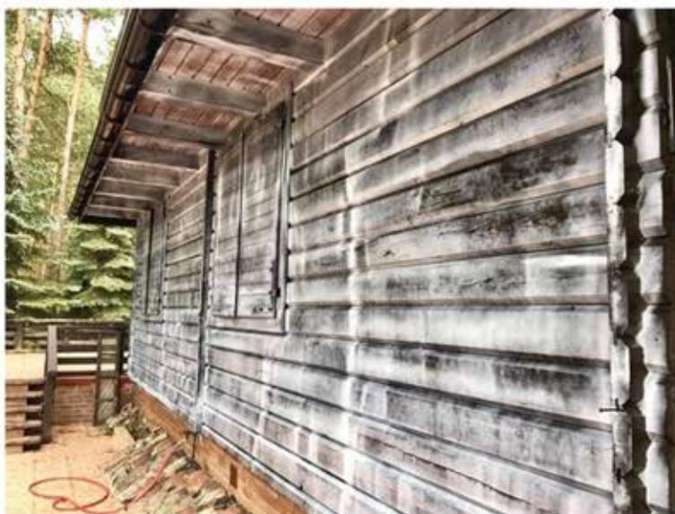
**Отличие** Ксилликс Геля от обычных жидких антисептиков и пропиток заключается в том, что густой гель можно нанести на древесину толстым слоем. Он не капает и не стекает с вертикальных поверхностей или потолка. Это позволяет нанести до 450 г на 1 м<sup>2</sup> препарата даже на вертикальные поверхности, как того требует технология производителя для обеспечения максимального проникновения и био защиты.
